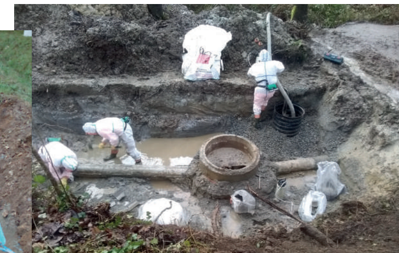
À gauche : Renouvellement du réseau rue de Bedernau et rue de Kerin Ci-dessus et ci-contre : remplacement de 51 regards
